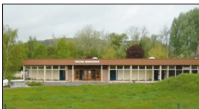
L'ancienne piscine avant démolition.
